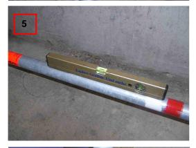
Ausgehend von dem U – Querriegel werden ringsum alle Riegel auf die Waagrechte aus- bzw. eingespindelt.
