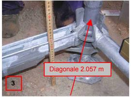
Wird die Oberkante des U – Querriegel mit ca. 22 cm gewählt, wird die unterste Stufenhöhe 25 cm und somit gleich entsprechend den Stufen der Treppen.
