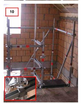
Am obersten Treppenaustritt muss seitlich vom Treppenlauf ein 2 – 3 teiliger Seitenschutz aus TR U-Querriegeln 0.78 M zwischen Leitpfosten und Vertikalstiel 1 m hergestellt werden. Dazu werden u. U. weitere klemmbare Lochscheiben angeschlossen.
