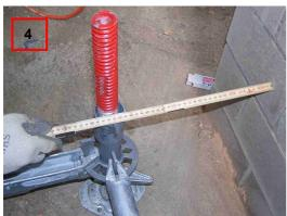
Durch Kontrollmessungen ringsum zu den Wänden wird der Rohbautreppenturm ausgerichtet.
