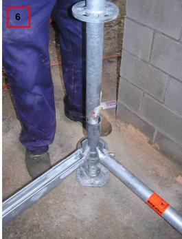
Über alle 4 Spindeln Vertikalstiele in die Anfangstücke einstellen.
