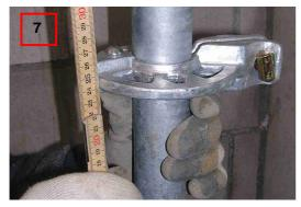
Die Lochscheiben klemmbar, geschmiedet ( 2602019 ) zur Halbierung des Lochscheibenabstandes müssen genau mittig zwischen 2 angeschweißten Lochscheiben eingebaut werden.
