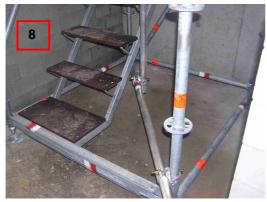
Zur Horizontal – Aussteifung und als Anschlag für den senkrechten Leitpfosten wird ein Gerüstrohr mit einer Mindestlänge von I = ca. 2,25 m diagonal über 2 Normalkupplungen an den Vertikal – Stielen angeschlossen.
